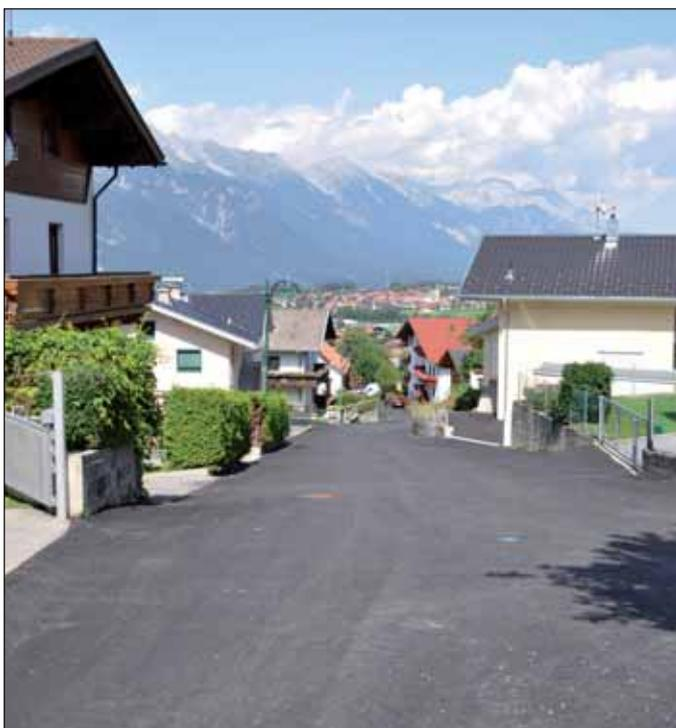
■ **Kalchgruben:** Aufgrund ständiger Aufgrabungsarbeiten der Anlagenbetreiber von Ver- und Entsorgungsleitungen (z.B. TI-GAS) wurde die Asphaltdecke derart in Mitleidenschaft gezogen, dass es notwendig war, diese zu erneuern. Teilweise musste auch der Straßenunterbau neu unterkoffert werden. Die Arbeiten wurden im Juni/Juli fertiggestellt und vor allem die Anrainer der Kalchgrubensiedlung können sich über den neuen Belag freuen.
