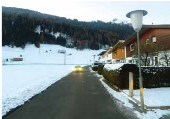
HQL Quecksilberdampf lampen werden ausgetauscht. Das Bild zeigt die Gemeindestraße Kreuzmoos in Blick Richtung Süden.
