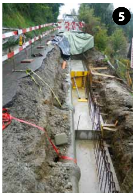
5 Fundamente sind betoniert.
