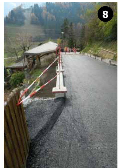
8 Nach dem Auftragen der Feinplanie und der Asphaltdecke konnte die Straße für den Verkehr wieder freigegeben werden.
