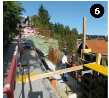
6 Das aufgehende Mauerwerk wird geschalt und betoniert.
