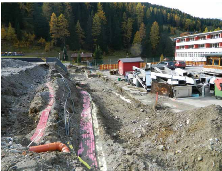
Neuer Wegabschnitt im Bereich zwischen Hotel Olympia und Hoadlbahn Talstation
