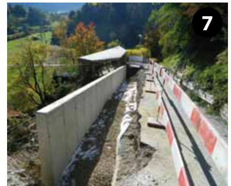
7 Nachdem die neue Mauer ausgeschalt ist, wurde ein Drainagerohr in einer Rollierung verlegt, und mit einem Vlies abgedeckt. Danach wird nach mehrwöchiger Aushärtungszeit der Frostkoffer geschüttet und verfüllt. Die Absturzsicherung mittels Holztaun wurde von der Axamer Firma Wolfgang Kapferer gefertigt. Fotos: Ing. René Sarg
