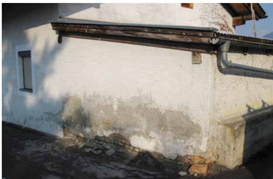
Die Sanierung war dringend notwendig!
