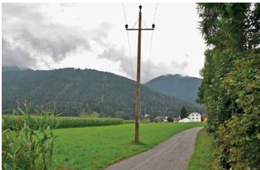
Im Bereich Bachl/Pafnitz ersetzt die TIWAG sechs baufällige Holzleitungstragwerke.
