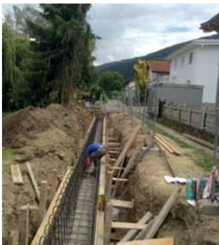
Bau der neuen Grenzmauer
