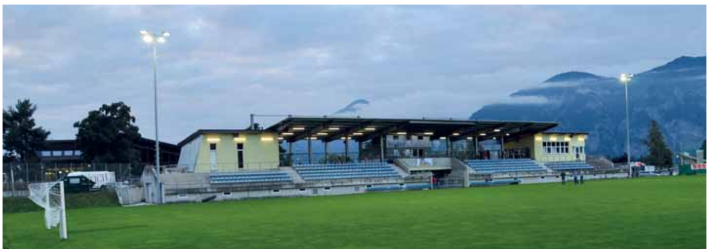
Am 31.7.2014 wurde das Flutlicht zum ersten Mal eingeschaltet.
