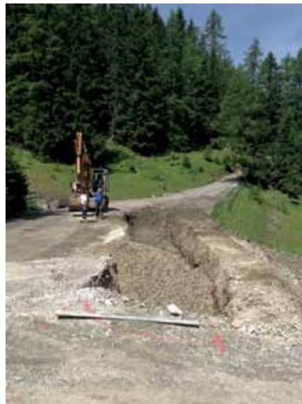
Sickermulde im Bau
