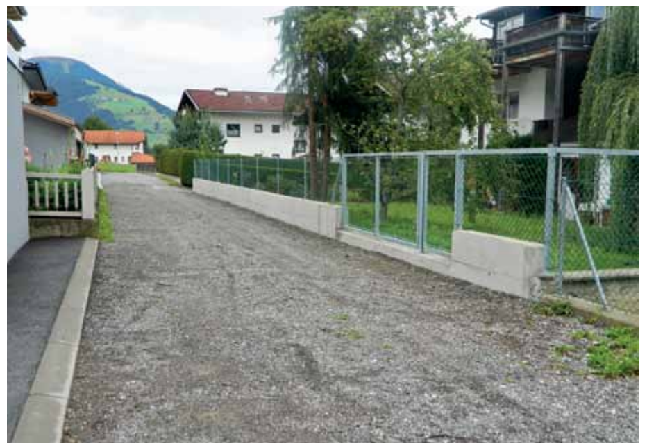
Die letzte Engstelle am Schießstandweg wurde beseitigt. Nun ist diese Gemeindestraße durchgehend befahrbar.
