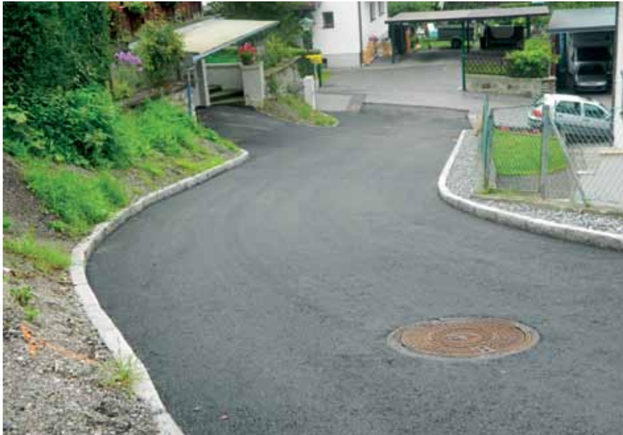
Fertiggestellte Auffahrt zum Panoramaweg im Bereich Kalchgruben
