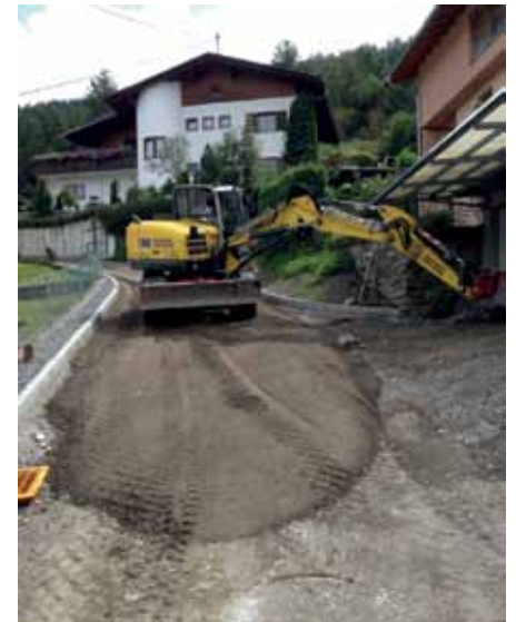
Auftragen der Feinplanie
