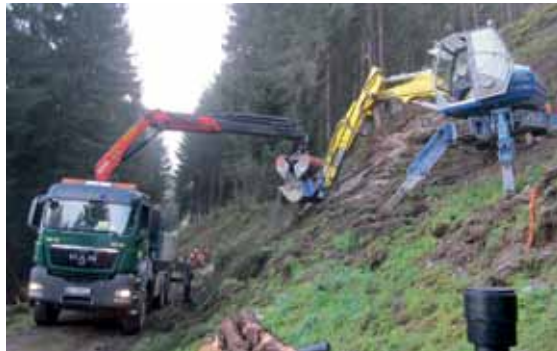
Schwierige Baggerarbeiten im Gelände
