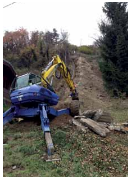
Die Grabungsarbeiten erfolgten in steilem Gelände.
