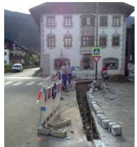
Verlegung der Randsteine
