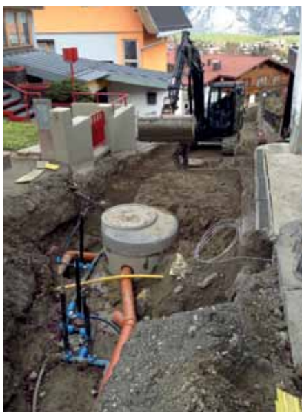
Sämtliche Leitungen wurden ausgetauscht.
