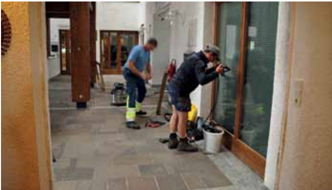
Die Demontage der alten Türen erfolgte durch die Gemeindearbeiter
