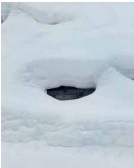
Quellkontrolle im Feber 2018 – Unterbrecherschacht Spiegellehner (oben) und Quellstube mittlerer Spiegellehner (unten) im tiefsten Winter
